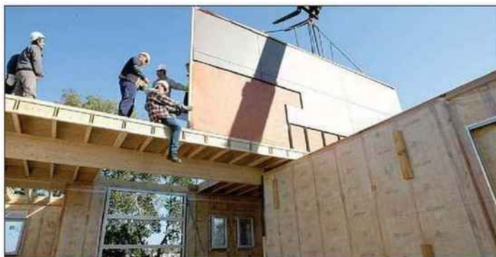
Des maisons construites ou surélevées avec du bois. ARCHIVES S. L.
